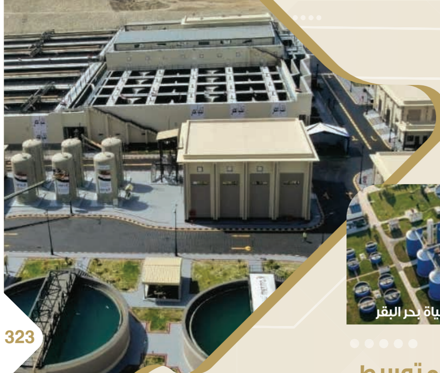
محطة معالجة مياه بحر البقر
